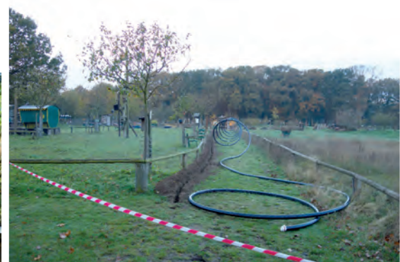
Verlegen der Wasserleitungen Fotos: Wiebke Esmann
