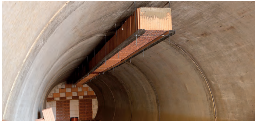
Der fertige Tunnel mit den Hohlblocksteinen; Foto: Rolf Cöhnen
