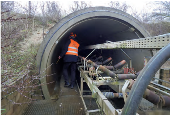
Der Fledermaustunnel – vor dem Ausbau Foto: Monica Sandrock
