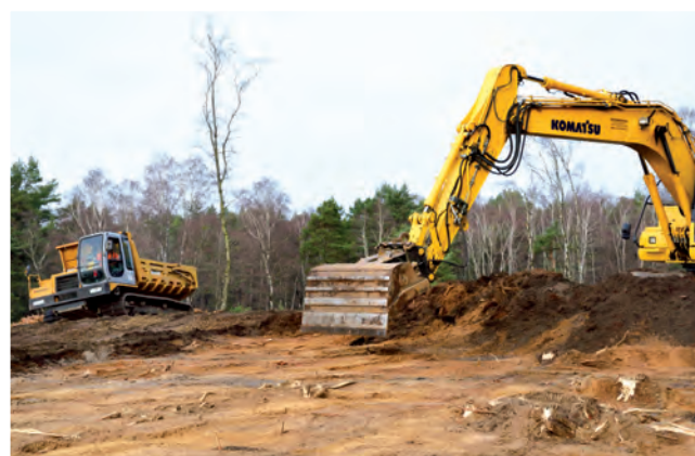
Spezialmaschinen legen den Sandboden wieder frei. Fotos: Hans-Georg Wende
